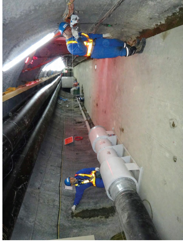
内空変位測定の様子 (250m調査坑道)
