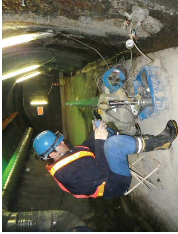
地下水の水質調査の様子 (140m調査坑道)
