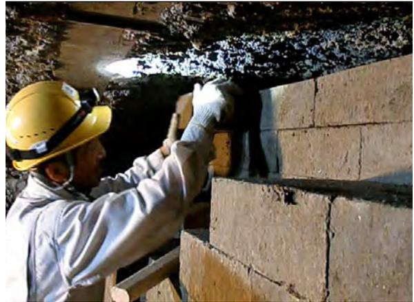
写真 10 埋め戻し材ブロックの
