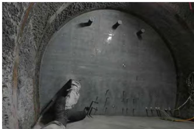
写真 13 コンクリートプラグ施工完了
