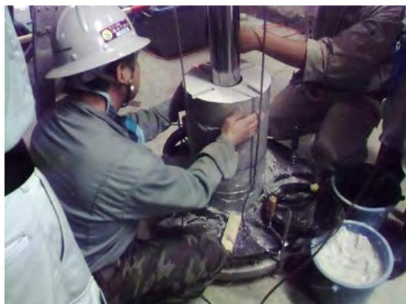
写真 17 ドーナツ型緩衝材の設置
