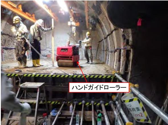
写真 9 埋め戻し材の転圧
