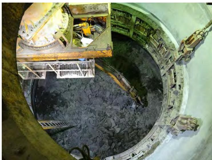
写真 41 地下施設の建設状況（東立坑の掘削）
