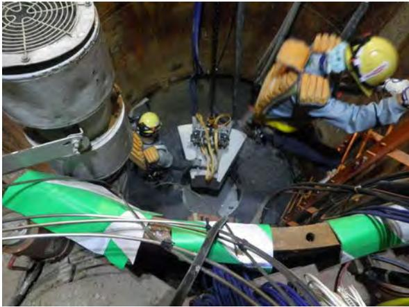
写真 3 緩衝材5段目設置
