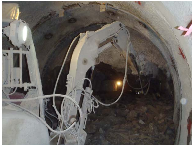
写真 18 350m 調査坑道貫通状況
