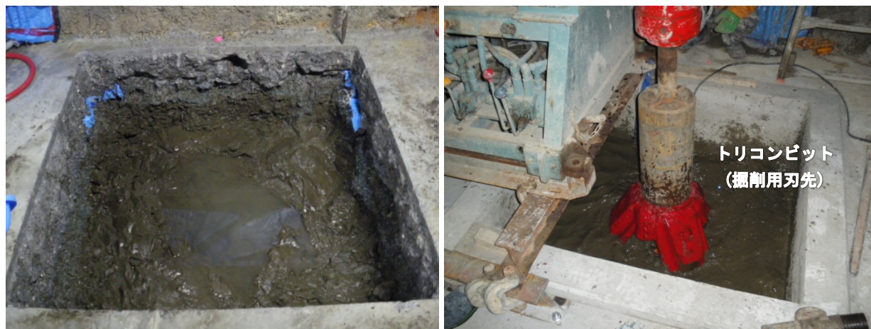
(a) 試験孔掘削前の岩盤 (b) 機械による試験孔掘削
