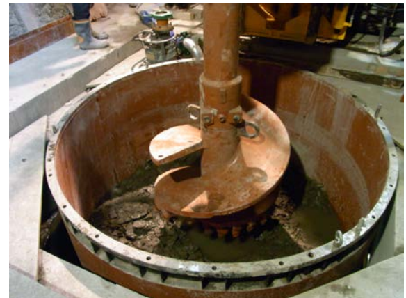
(c) オーガー工法による中掘
