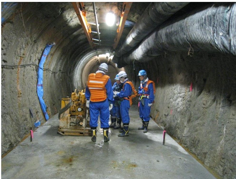
写真 19 安全パトロールの様子
