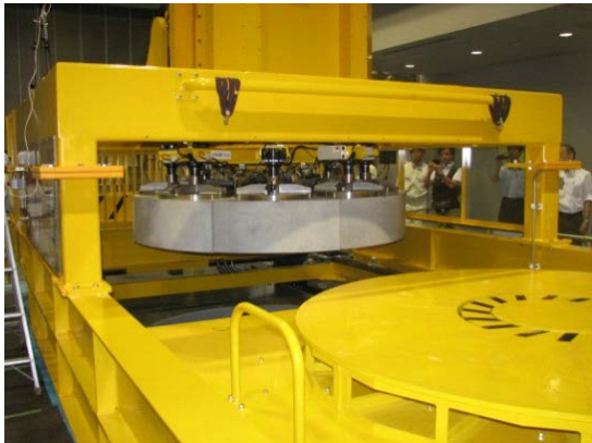
(2) 真空把持装置で緩衝材ブロックを把持し、緩衝材台車を戻す
