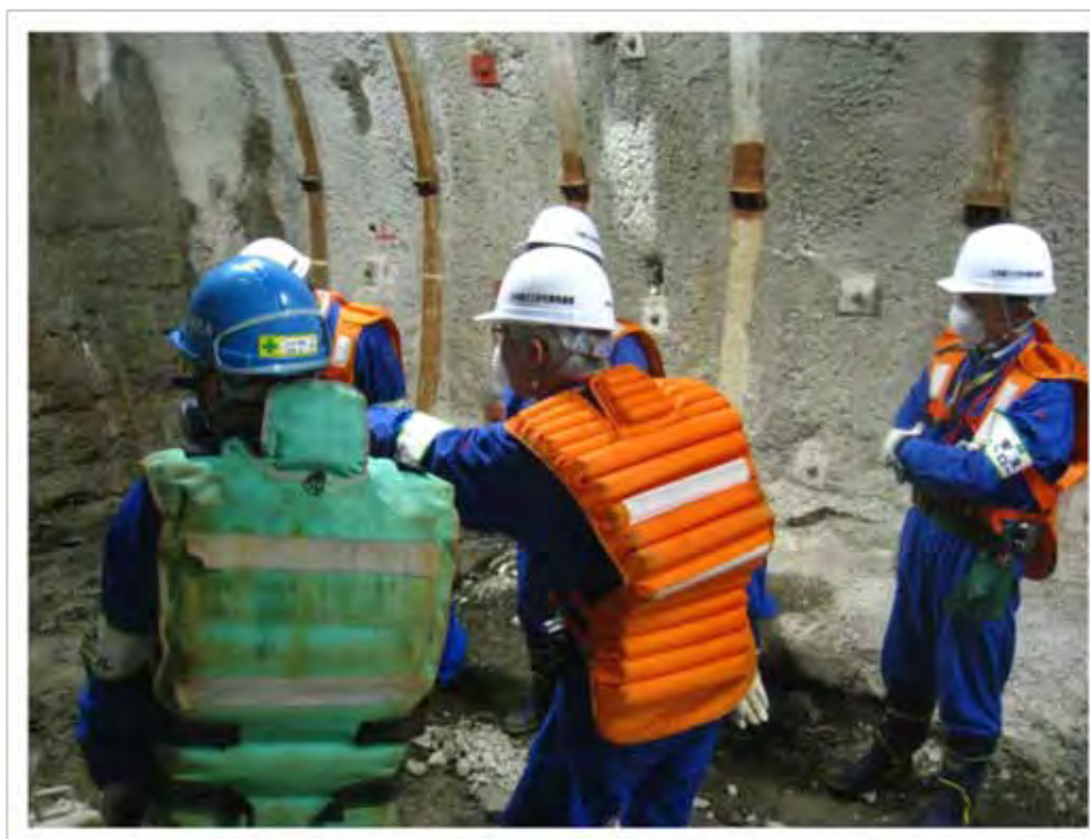
安全パトロールの様子
