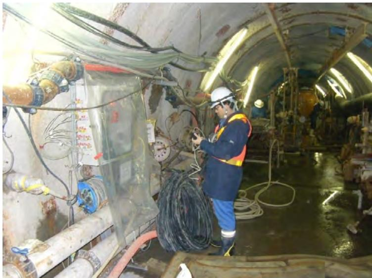
地下水の水圧・水質モニタリングの様子
