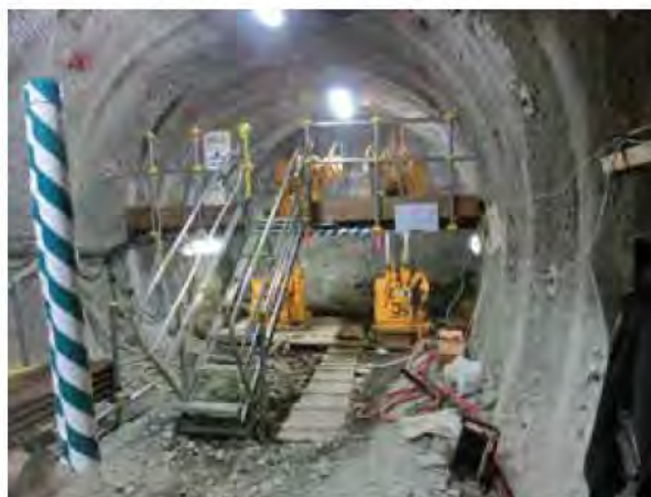
深度350m調査坑道 (平成24年8月24日撮影)
