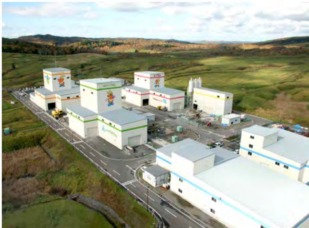
地下施設建設現場 (平成24年10月26日撮影)
