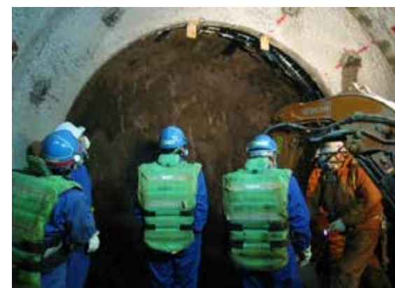
坑内パトロール (平成24年1月)
