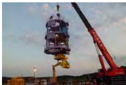
スcaffold投入(23年9月)
