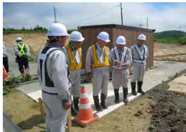
役員安全巡視 (平成23年8月)
