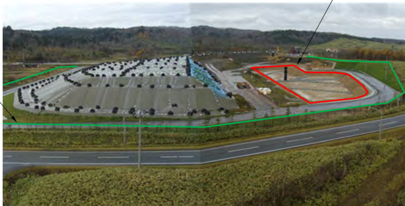
掘削土(ズリ)置場(23年11月)
