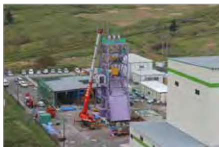
やぐら設備設置(23年10月)
