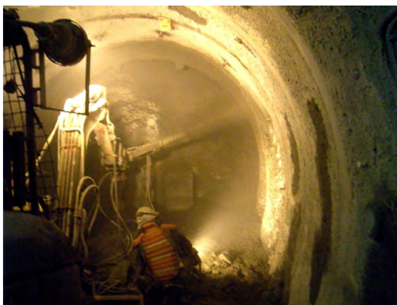
低アルカリ性コンクリート材料の吹付け状況 (140m調査坑道の例)
