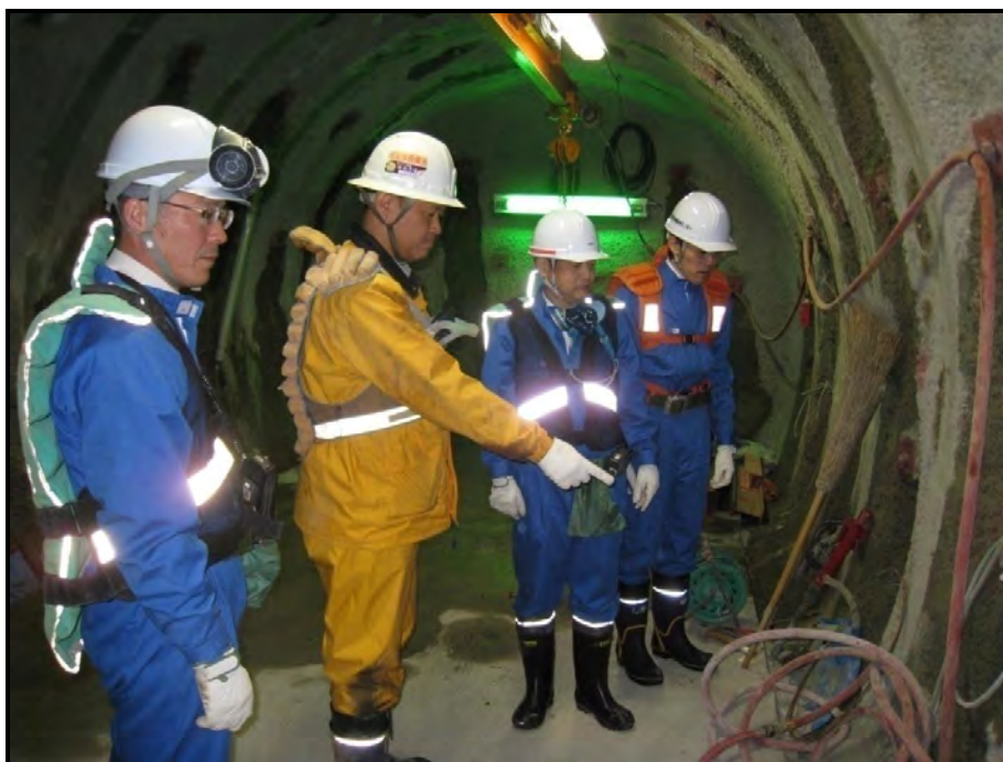
安全パトロールの様子
