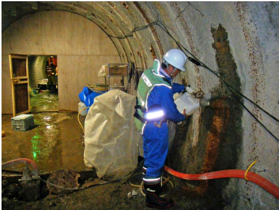
地下水採取の様子 (250m調査坑道)
