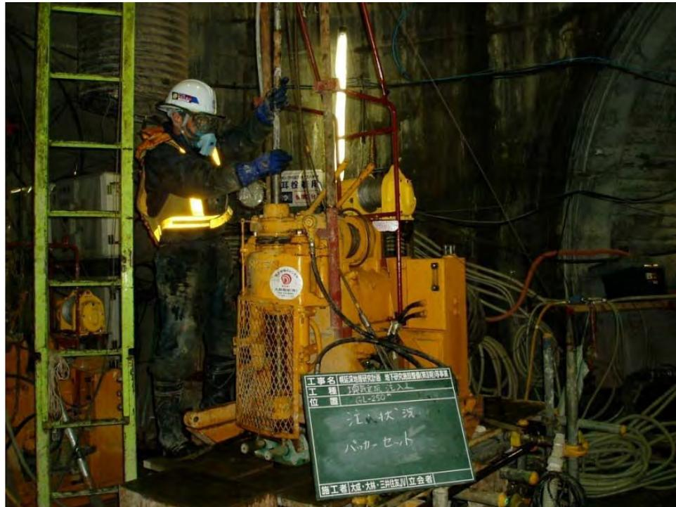
換気立坑深度250m地点におけるグラウト工事の様子
