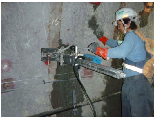
周辺岩盤への影響を調査するため、140m調査坑道からコンクリート及び岩石のコアを採取
