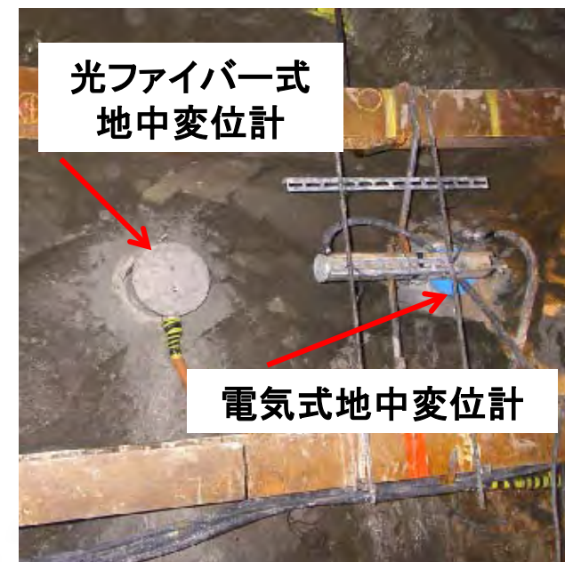
地中変位計の設置状況
