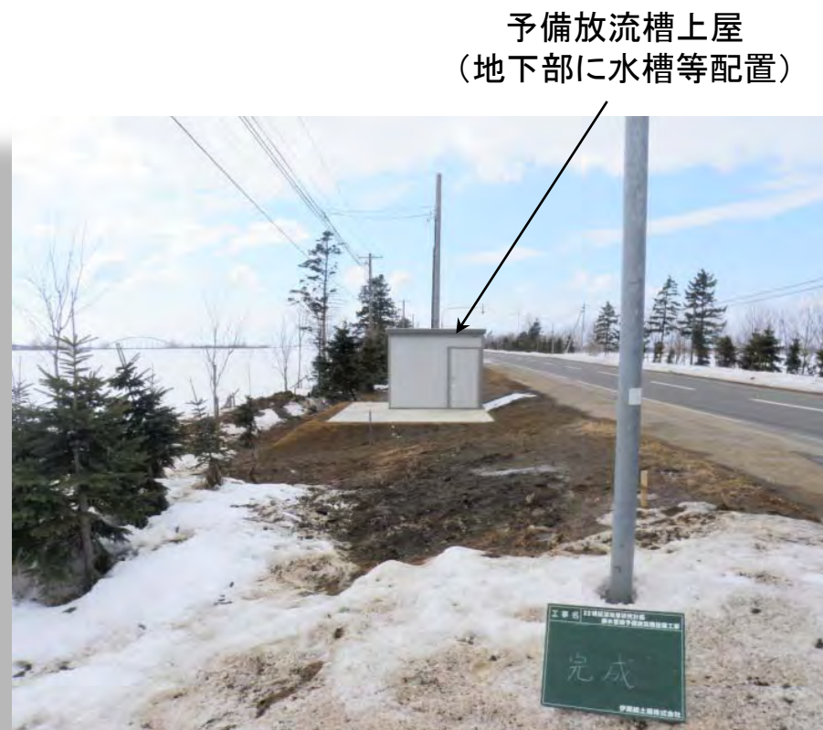
予備放流槽(23年3月)
