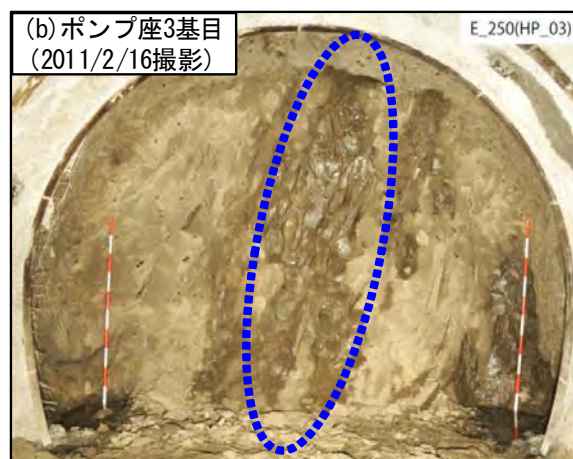
250m調査坑道における湧水割れ目のイメージと切羽写真
