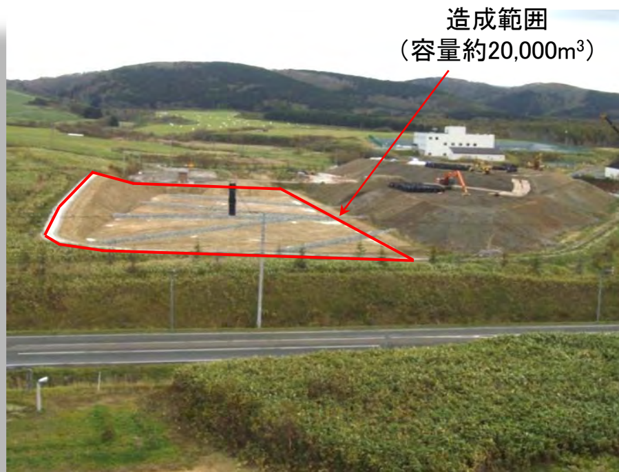
掘削土(ズリ)置場(22年10月)
