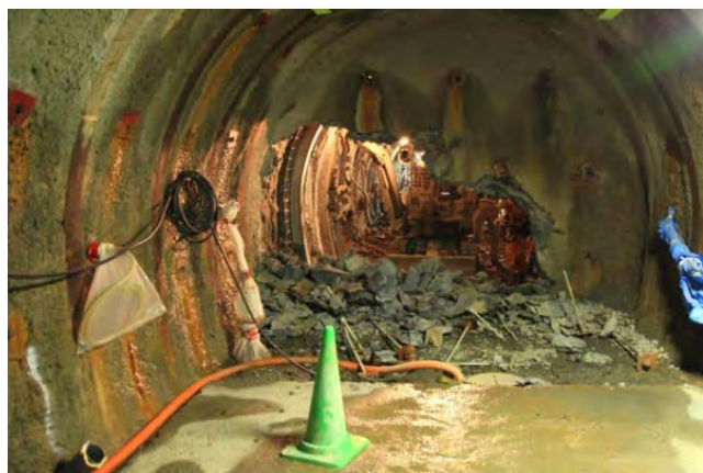
250m調査坑道貫通(22年6月)
