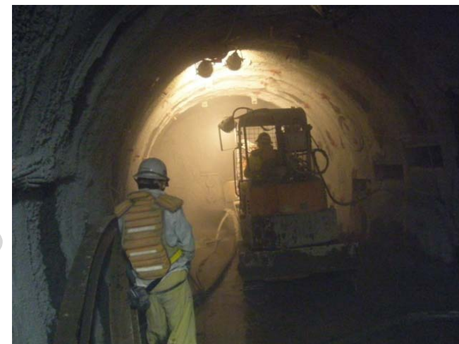
HFSCを用いた吹付けコンクリートの原位置施工試験
