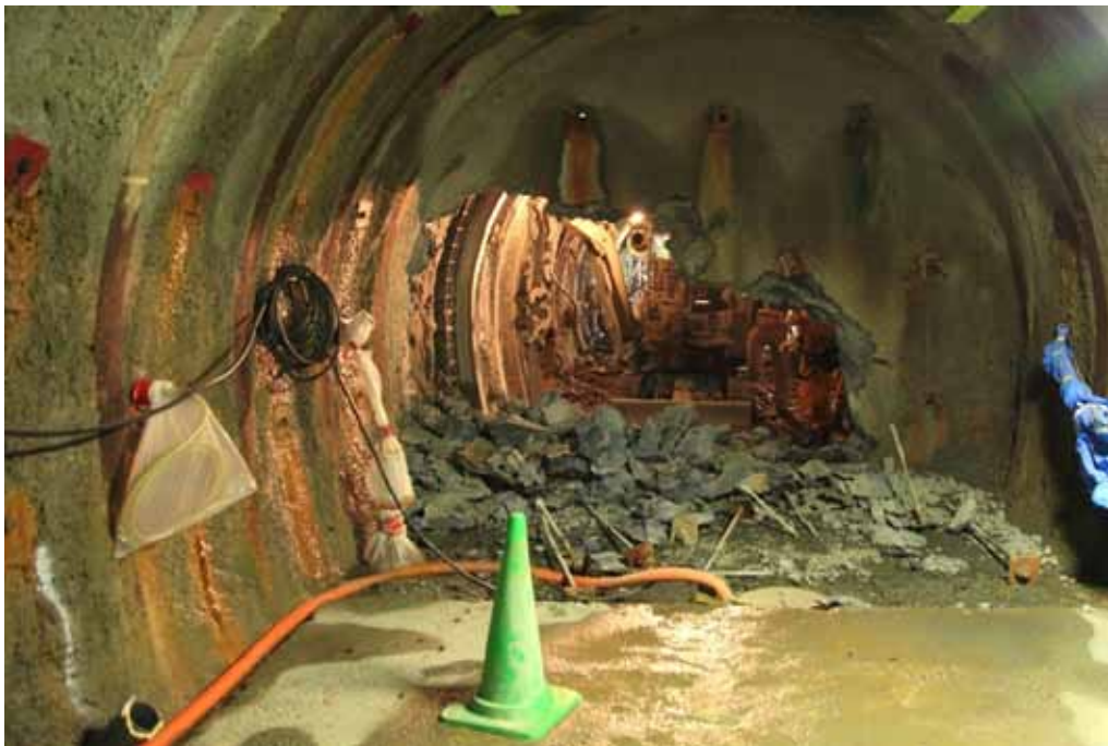
図 8 250m調査坑道貫通の状況
