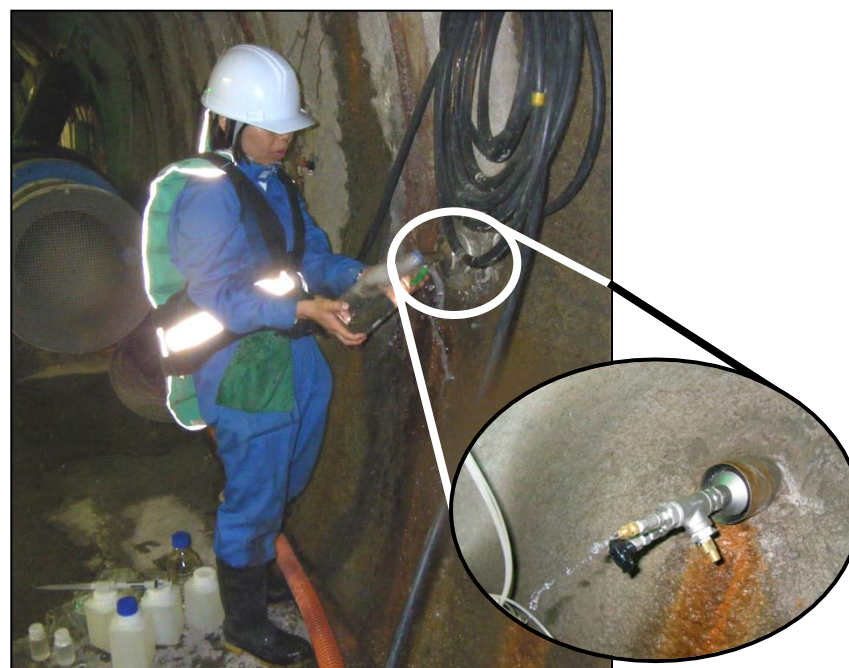
地下水採取の様子 (250m調査坑道)
