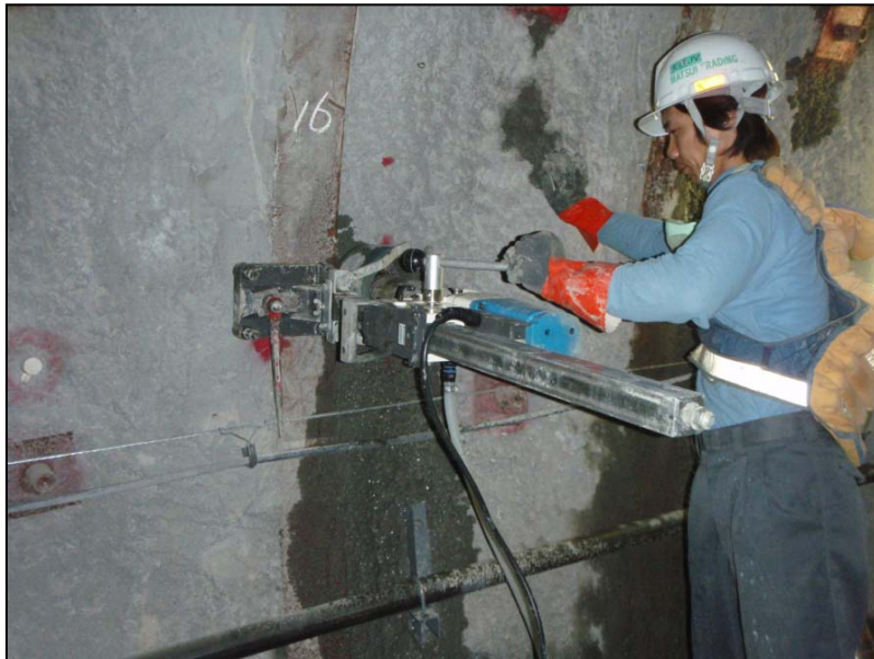
低アルカリ性コンクリート材料の 影響評価のためのコア採取 (140m調査坑道)
