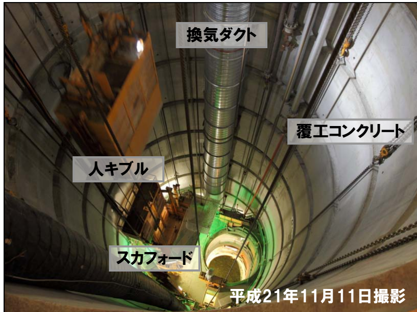
東立坑の状況 (東立坑深度140mから坑底を望む)
