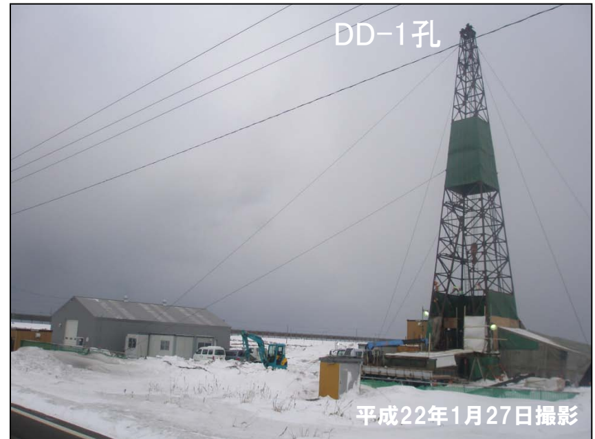
沿岸域を対象としたボーリング調査の様子 (浜里地区での調査)
