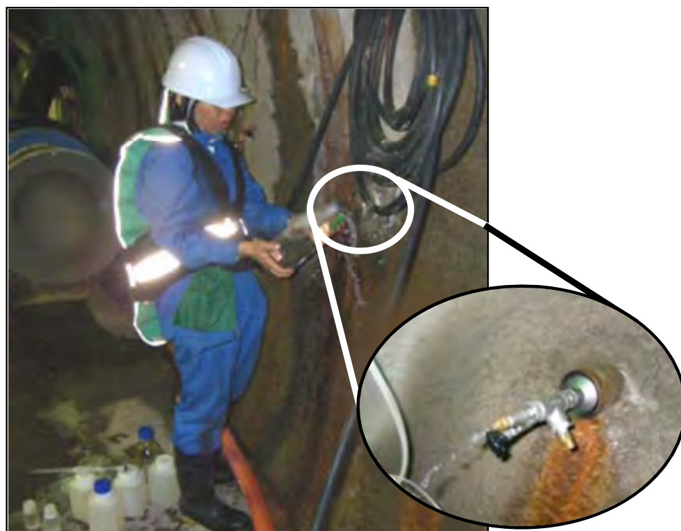
地下水採取の様子 (250m調査坑道)
