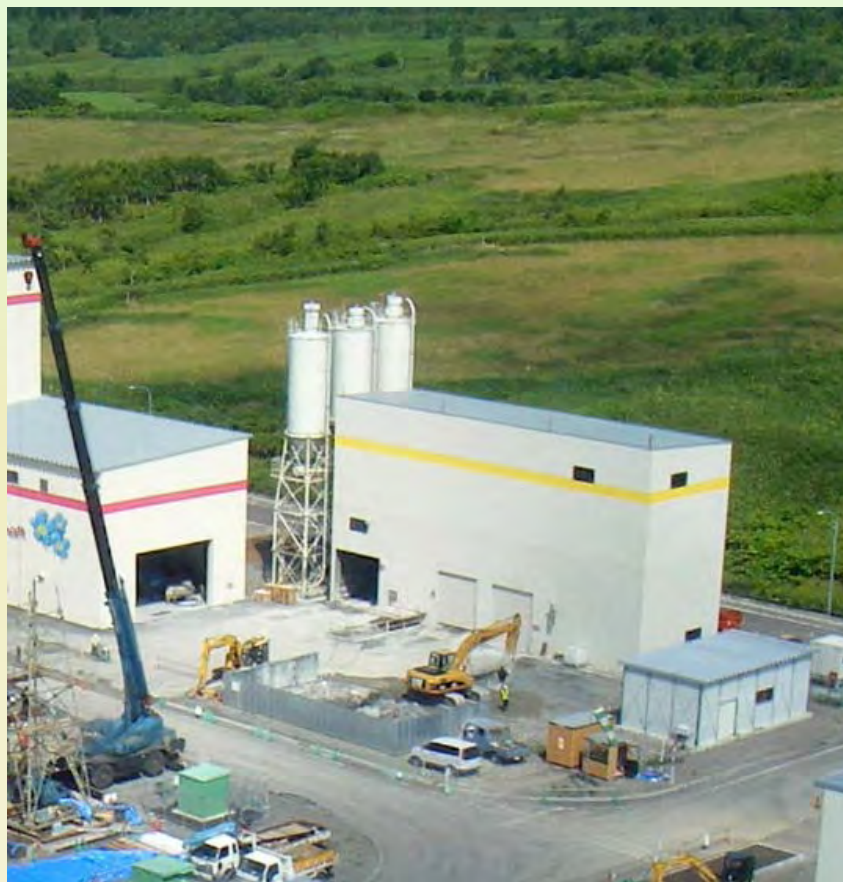
地上のプラント設備 (ゆめ地創館のタワーの展望台から撮影)
