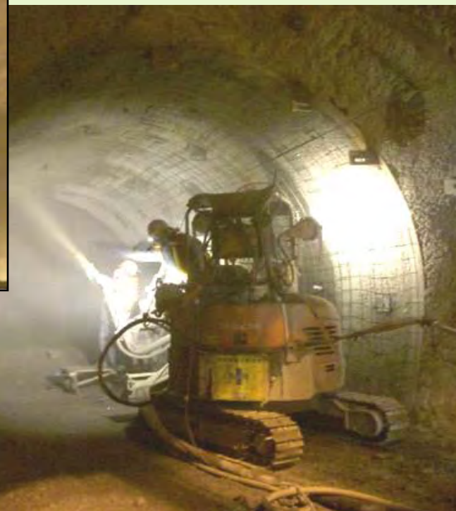
坑道への吹付け状況 (ノズルから噴射)
