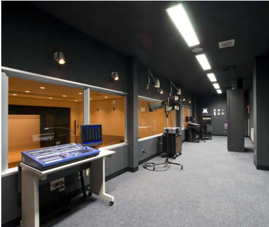
映写・音響室 国際会議同時通訳ブース
