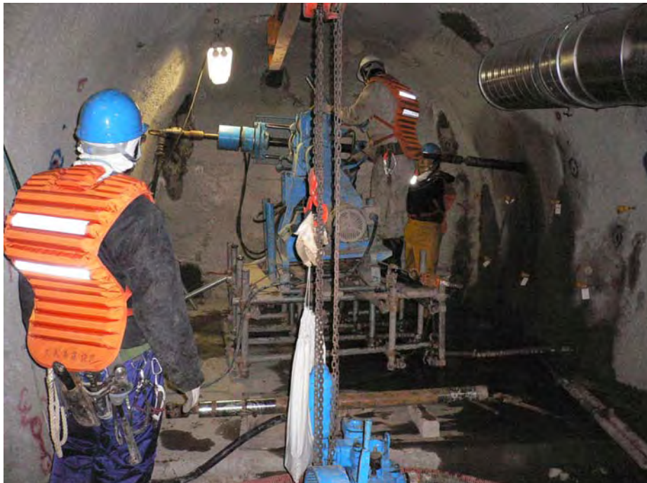
水平坑道からのボーリング調査の様子 (東立坑の深度140m)
