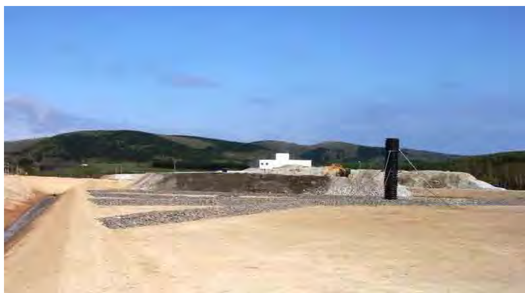
図 54 掘削土(ズリ)置場の盛土・保管状況
