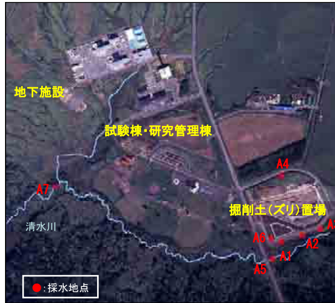
図 57 掘削土(ズリ)置場とその周辺の水質モニタリング調査位置
