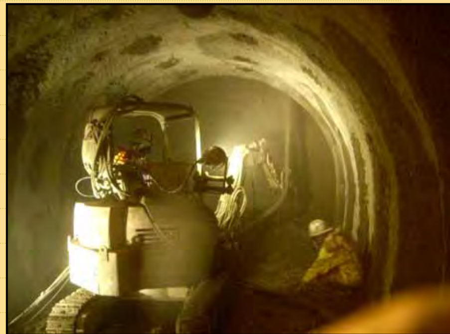
吹付け施工試験のイメージ (換気立坑：70mポンプ座での普通コンクリート材料による吹付けの様子)
