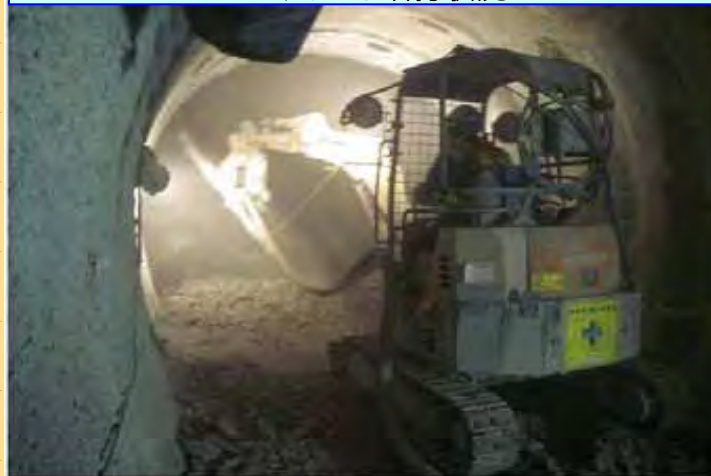
コンクリート吹付状況
