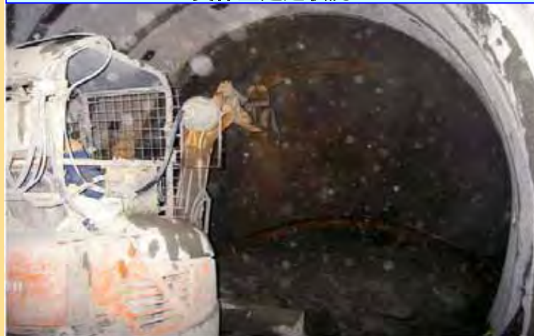
支保工建込状況
