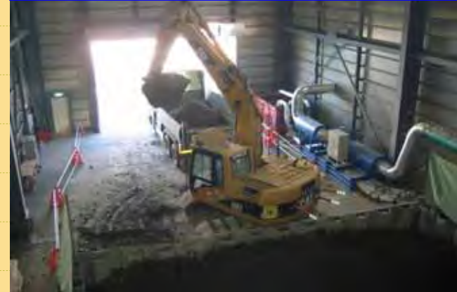
掘削土(ズリ)積込状況
