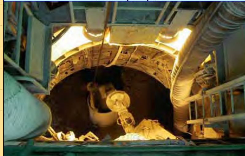
掘削土(ズリ)積込
