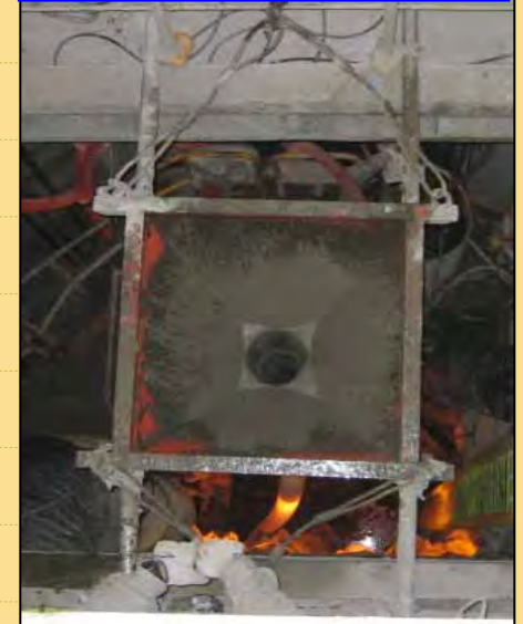
コンクリートシュート設置
