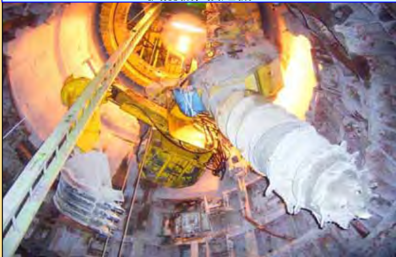
掘削機、積込機
