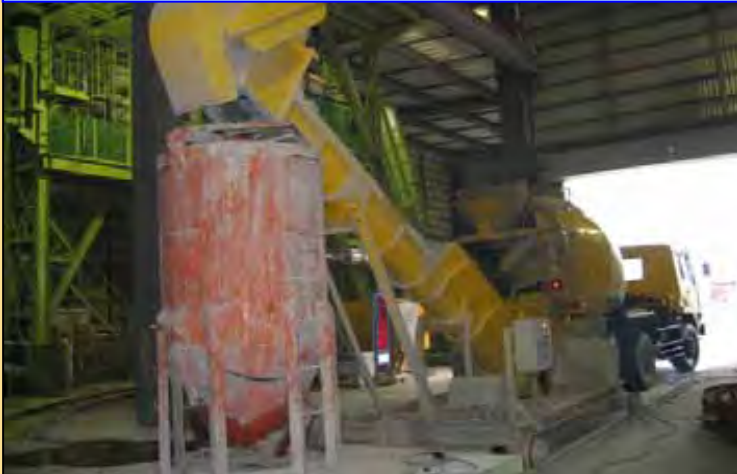
コンクリート積み込み
