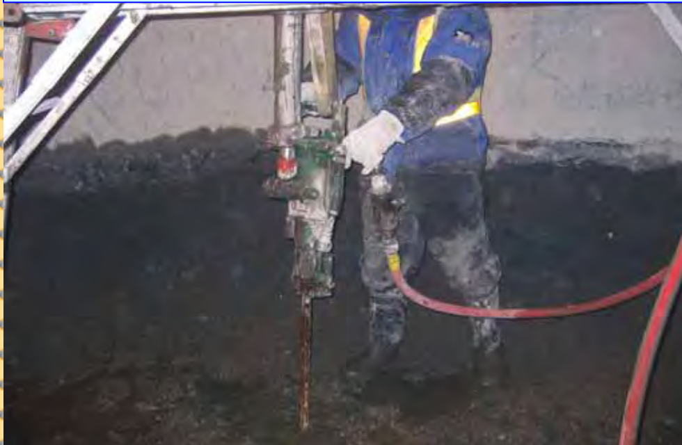
ガスチェックボーリング削孔
