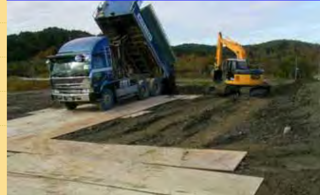
掘削土(ズリ)置場搬入状況
