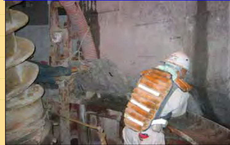
コンクリート打設
