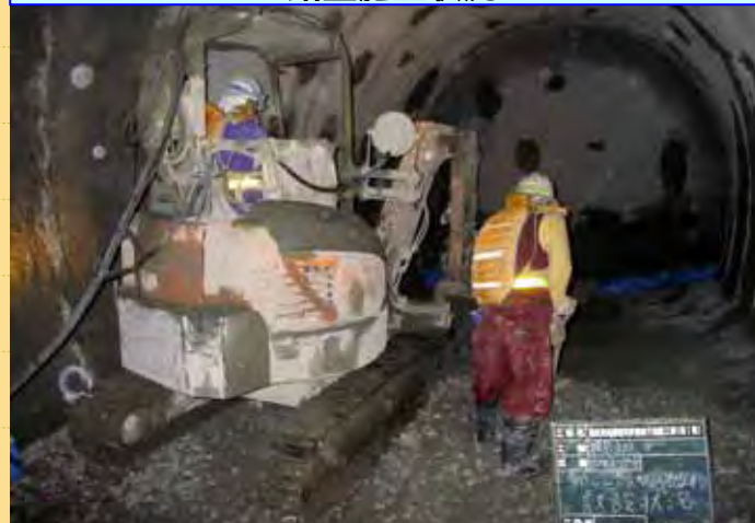
路盤施工状況
