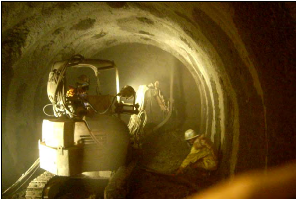
吹付け施工試験のイメージ (換気立坑：深度70mポンプ座での普通コンクリートの吹付けの様子)
