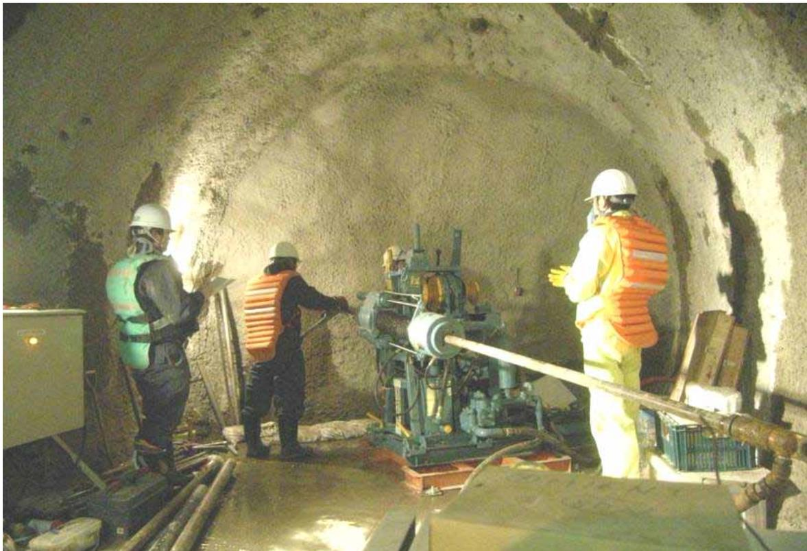
図 15 換気立坑小型試錐座における初期地圧測定用ボーリング孔 (図 14 の 孔) の掘削状況
