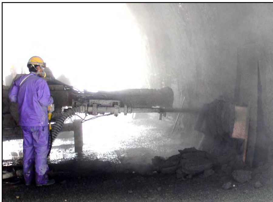
低アルカリ性コンクリート材料の 施工試験の例 (型枠への吹付け試験)
