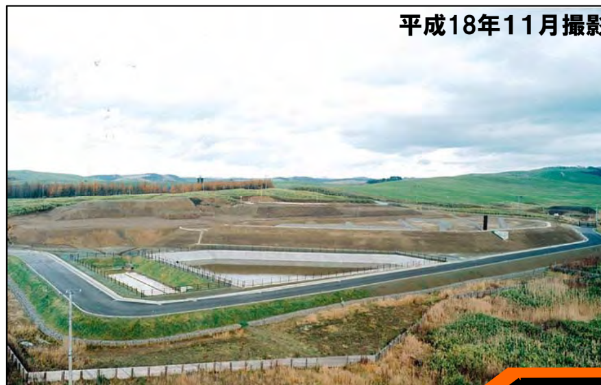
掘削土(ズリ)置場の様子
