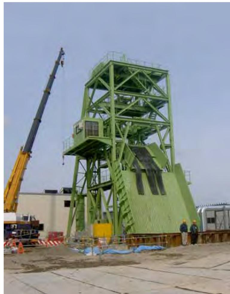
換気立坑 櫓設備の組立完了
