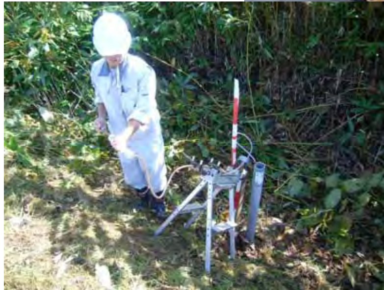
地質調査(ガス調査)の例
