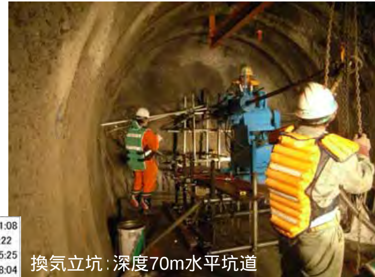
測定用ボーリング孔の掘削
