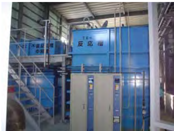
(c) 脱窒素（アンモニア）設備
