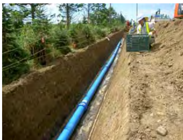
(b) 排水管路敷設状況
