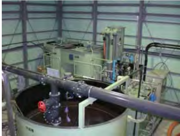
(a) 濁水処理設備
