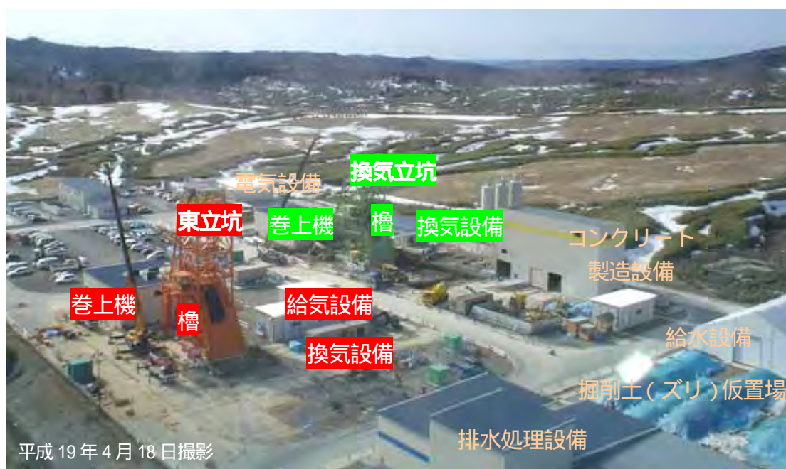
図 55 地下施設関連設備
