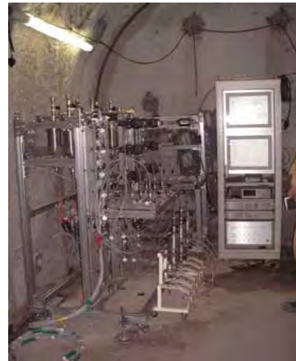
立坑内での地下水の地球化学モニタリングと採水装置
