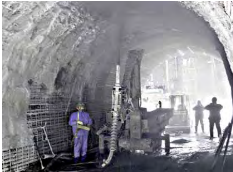
低アルカリ性コンクリート材料の 施工試験の例 (模擬トンネルへの吹付け試験)
