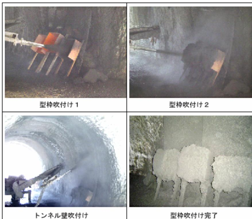
図 52 吹付け試験の様子（HFSC424N）
