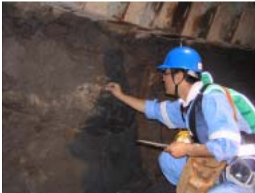
立坑壁面観察状況
