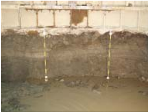
立坑壁面状況
