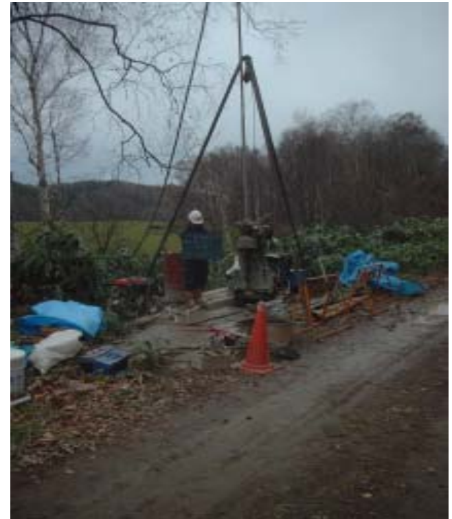
地質調査(試錐調査)の例
