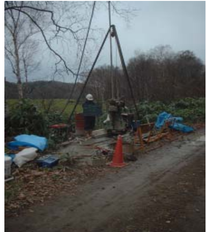
地質調査(試錐調査)の例
