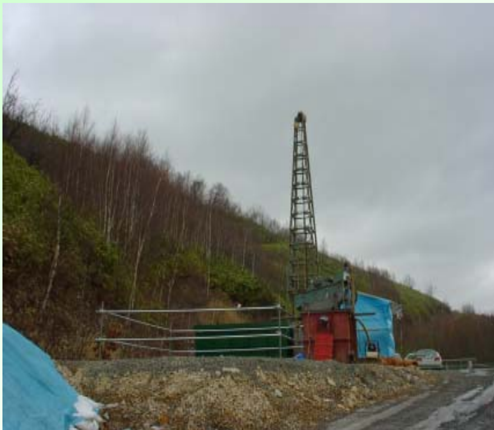
HDB-2孔敷地内における 地震計埋設用試錐孔掘削現場
