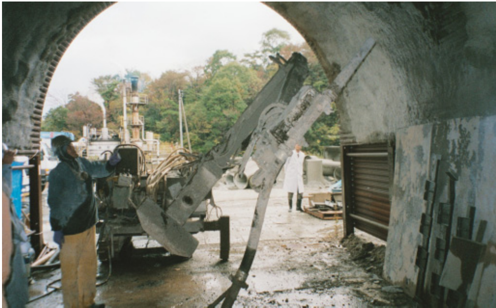
図 36 模擬トンネルでの吹付け試験状況
