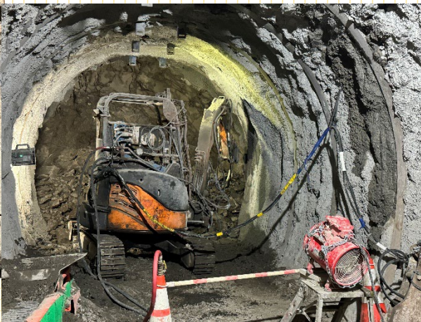
500m調査坑道の掘削状況
