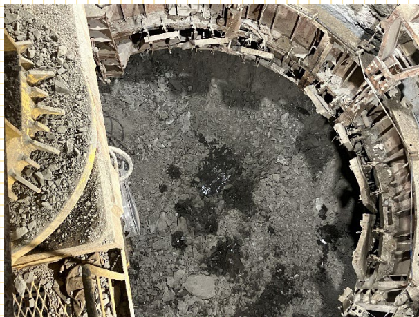
換気立坑深度500m到達時
