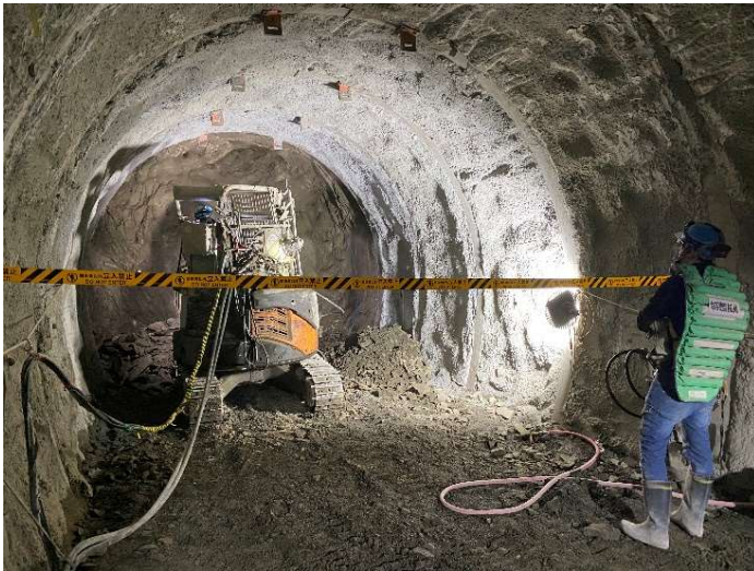
試験坑道7掘削状況
