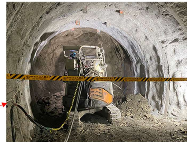
試験坑道7の掘削の様子
