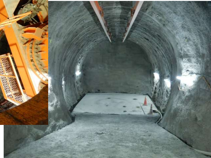
東立坑側第1ボーリング横坑
