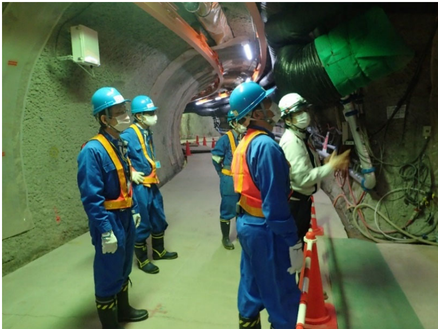
安全パトロールの様子
