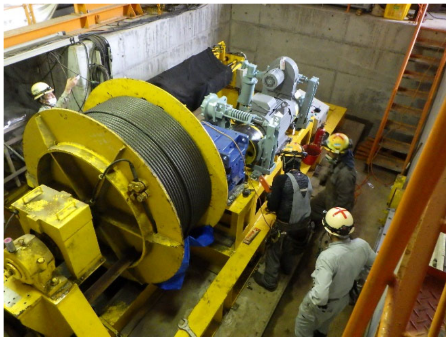
令和3年度に行った巻上機の整備の様子
