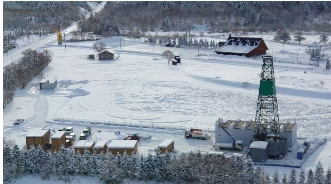
ボーリング調査現場の全景
