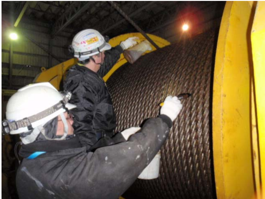
機械設備の維持管理の様子
