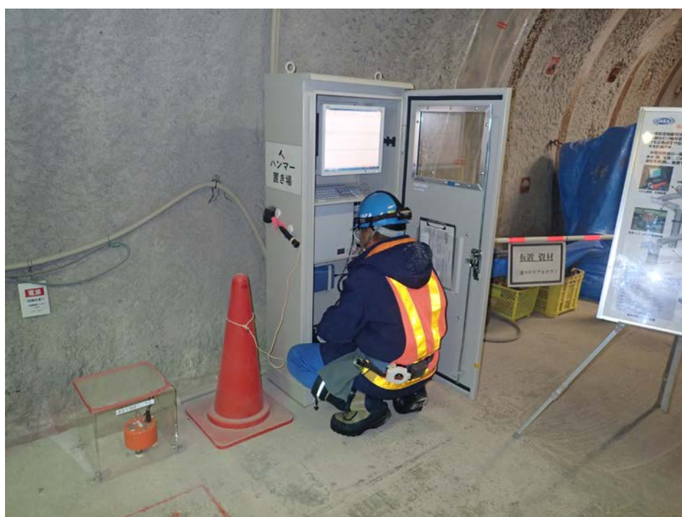
地震観測モニターの動作状況確認の様子 (深度350m調査坑道)
