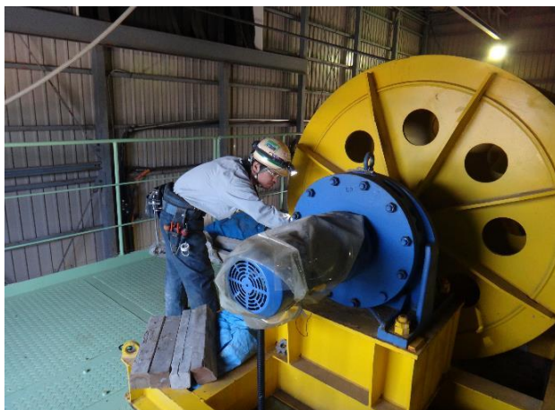
スcaffolding(吊り足場) 巻き上げ機の点検
