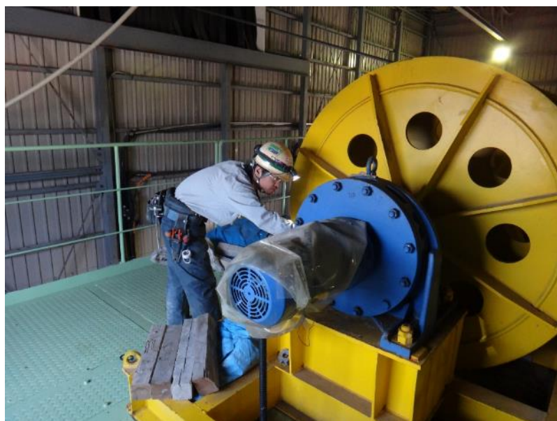
写真 7 スカフォード（吊り足場）巻き上げ機の点検
