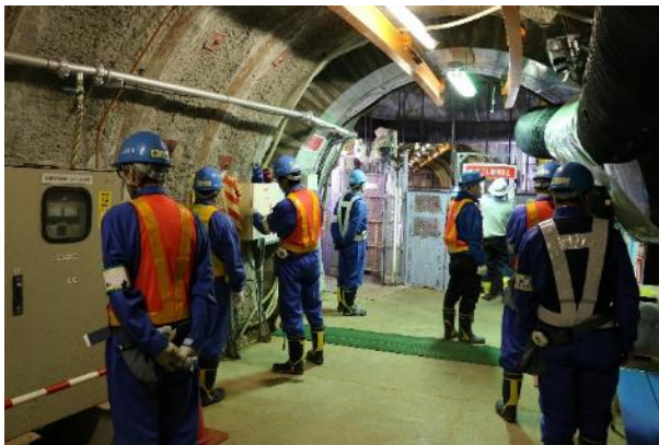
写真 16 安全パトロールの状況
