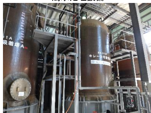
脱ホウ素設備 (2号機)
