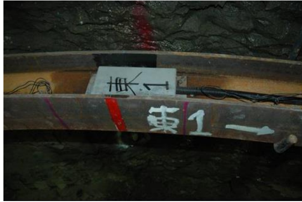
図 46 鋼製支保工応力計設置例
