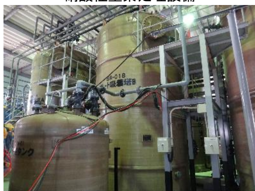
脱ホウ素設備 (1号機)
