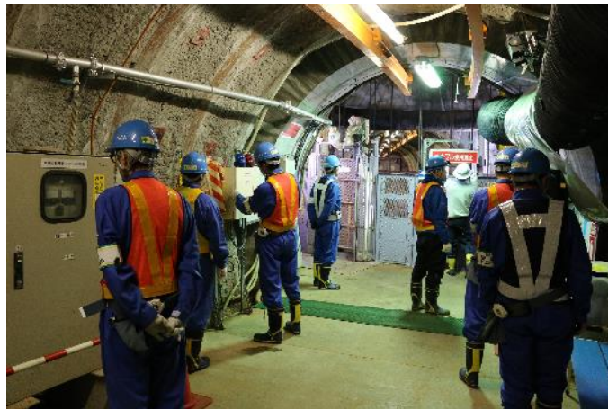
写真 16 安全パトロールの状況
