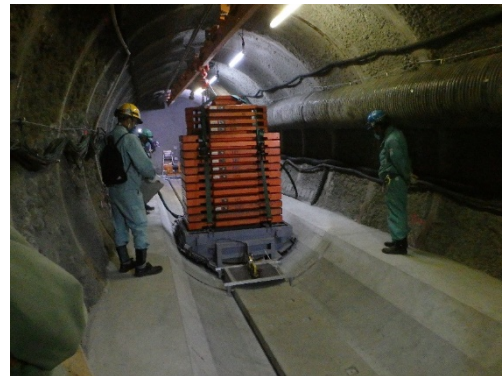
PEM相当の重量の搬送試験
