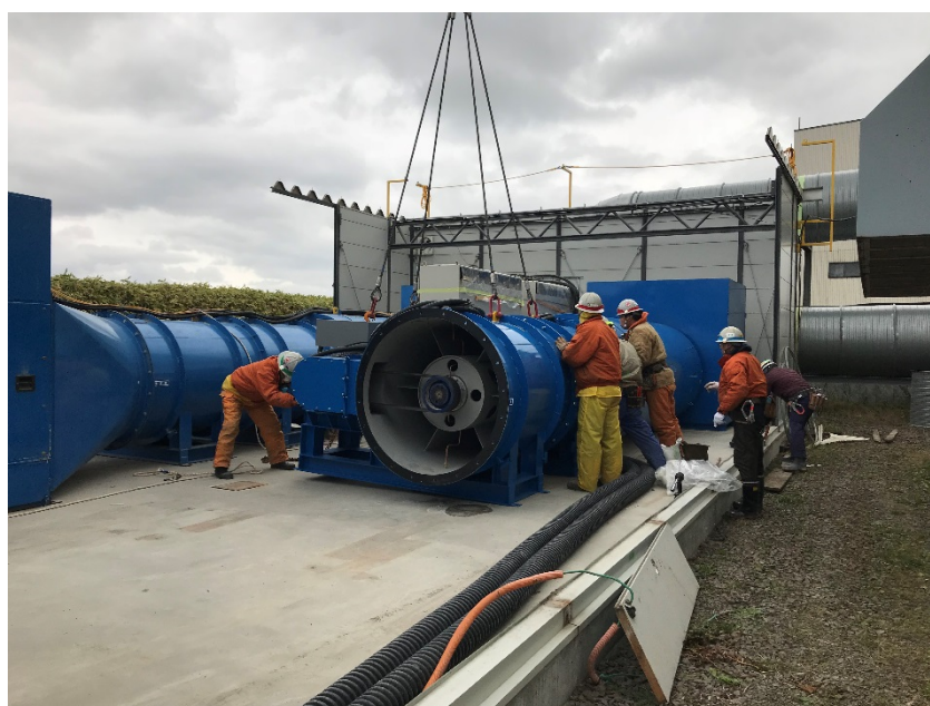
写真 6 坑内換気用主要ファン・集塵機(1号機)の整備
