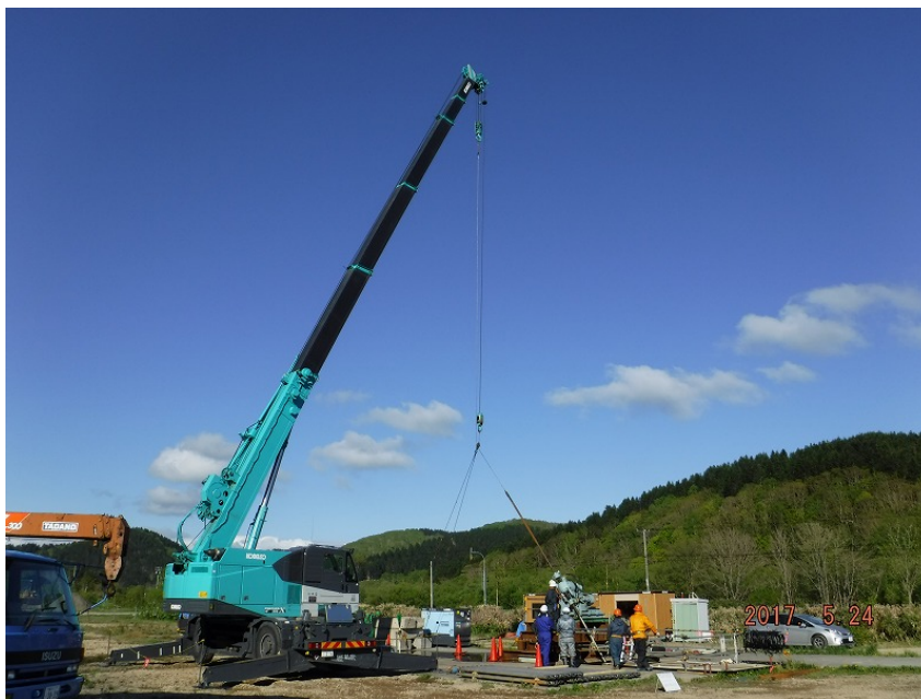
写真 1 コントロールボーリング孔内に設置されていた モニタリングシステムの回収作業の様子
