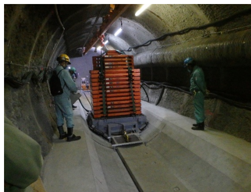
PEM相当の重量の搬送試験
