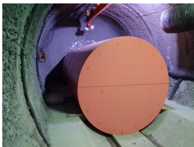
写真 5 模擬 PEM の設置状況(試験坑道 2)
