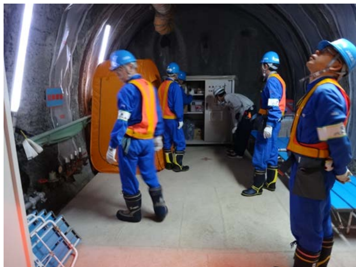
写真 15 安全パトロールの状況
