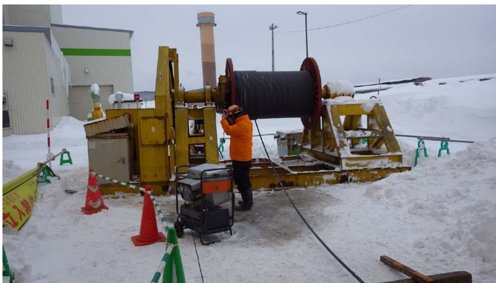
写真 7 人キブル(工事用エレベータ)のワイヤロープ交換
