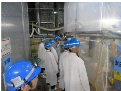
現場視察/プラスト除染に関する説明の様子
