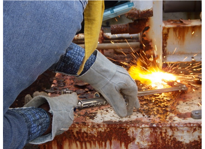
解体対象をガス溶断にて解体する様子 (重水 (I) 建屋屋上空調設備の解体作業)
