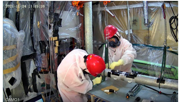
装置の組立・挿入作業
