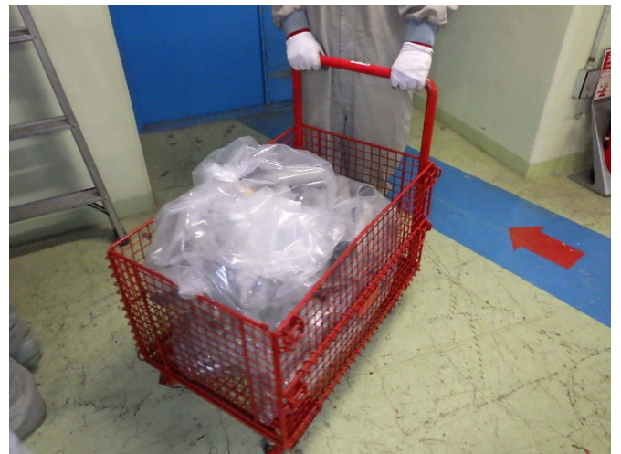
仕分・分別した解体撤去物を運搬する様子 (復水系計装ラック等の解体撤去作業)
