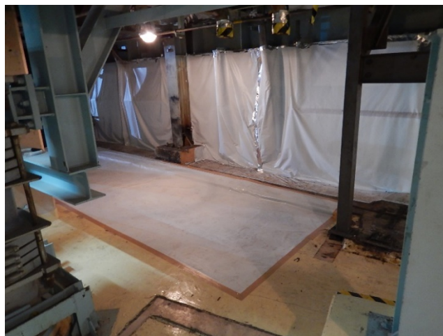
冷却材再循環系マニホールド 撤去後
