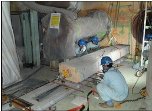
乾式ワイヤーソー切断後のコンクリート ブロック引き抜き作業
