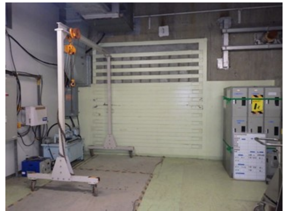
遮へい壁貫通前
