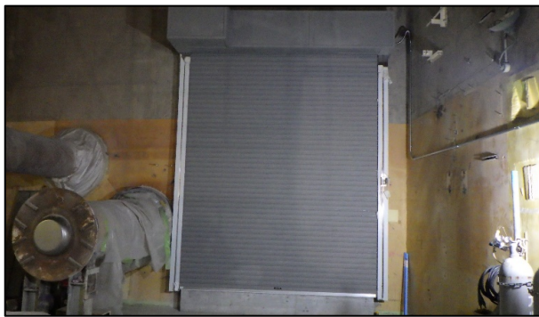
シャッターの設置状況
