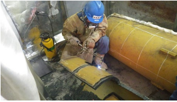
主蒸気配管の細断（ガス溶断）
