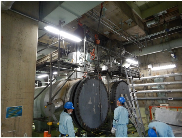
海水系熱交換器の開放点
