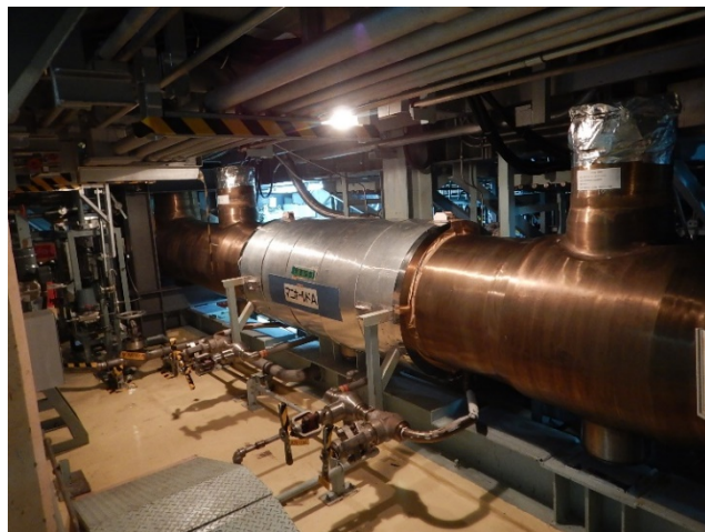
冷却材再循環系マニホールド 撤去前
