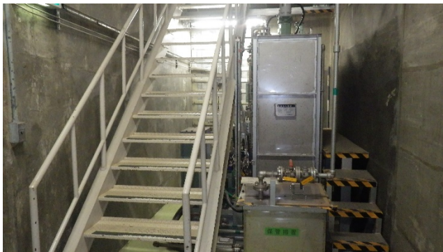
亜鉛注入設備（解体前）
