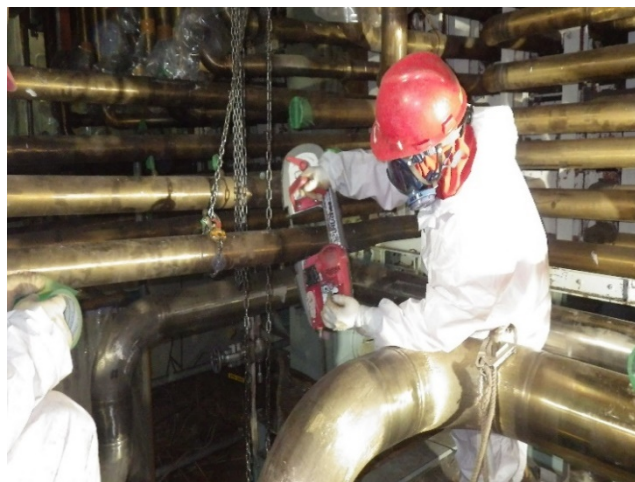
上昇管切断状況（バンドソー）
