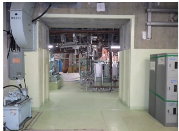
遮へい壁貫通後
