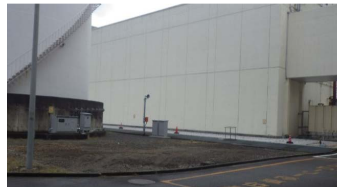
炭酸ガス供給設備の解体後
