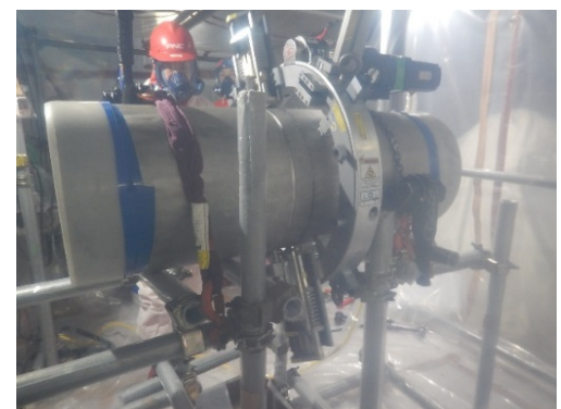
開先加工機による切断実証
