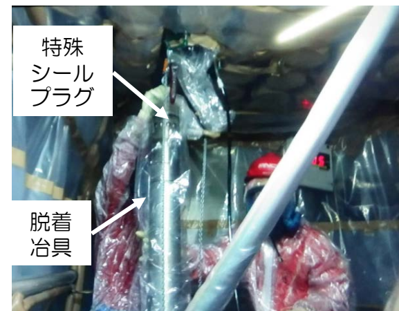
写真 2. 特殊シールプラグ取外し状況
