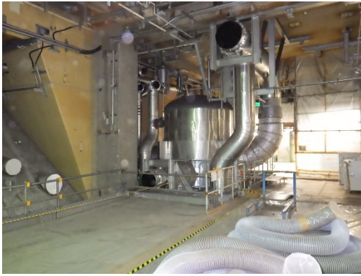
(湿分分離器解体撤去前)
