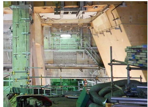
(B 復水器解体撤去後)
