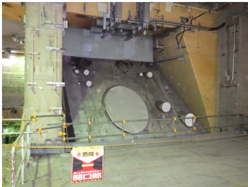
(B 復水器上部解体前)
