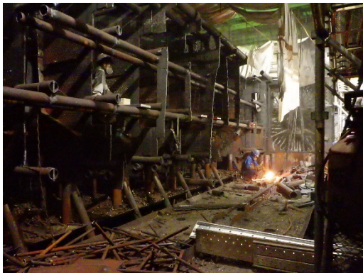
(復水器内部切断作業状況)
