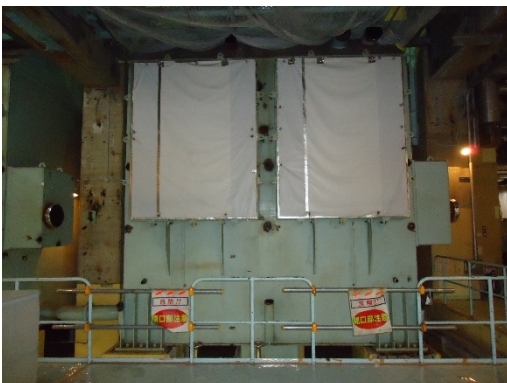
(B 復水器下部解体撤去前)
