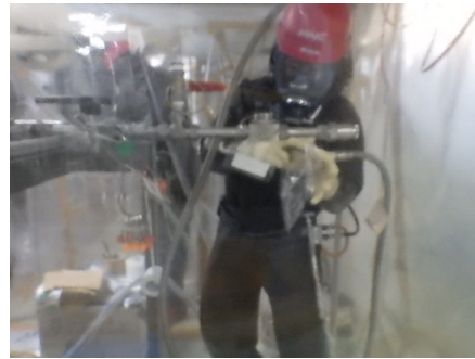
(トリチウム水回収治具設置)
