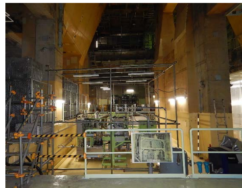
(B 復水器下部解体撤去後)
