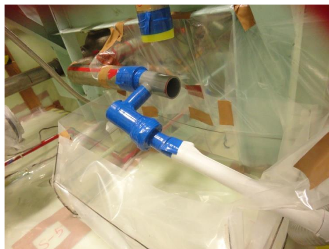
汚染の除去工事状況 （除染用ポートの接続）
