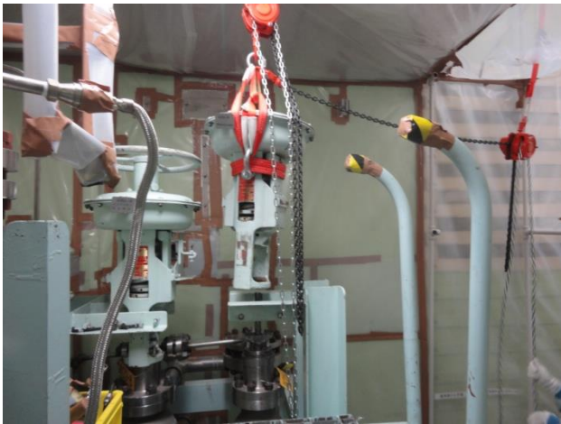
解体撤去工事状況 (汚染の無いエアークラップ駆動部の解体撤去)
