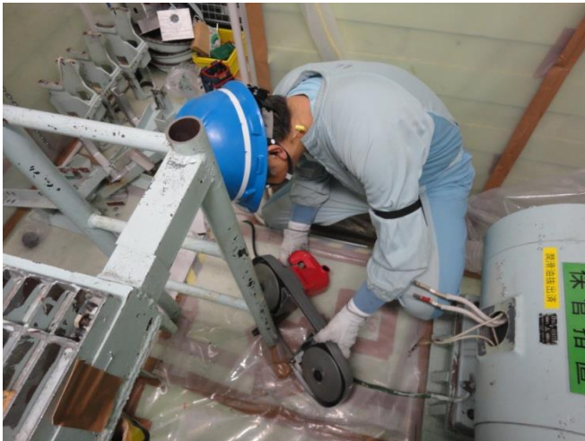
解体撤去工事状況 (汚染の無い架台等の解体撤去)
