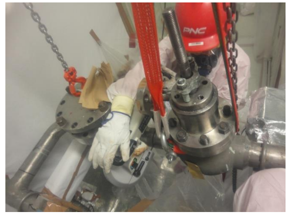
解体撤去工事状況 (汚染を内包する弁本体の解体撤去)
