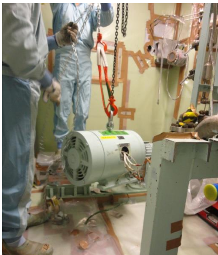
解体撤去工事状況 (汚染の無いポンプモータ部の解体撤去)
