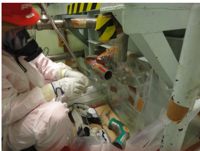
汚染の除去工事状況 （除染対象配管の切断）
