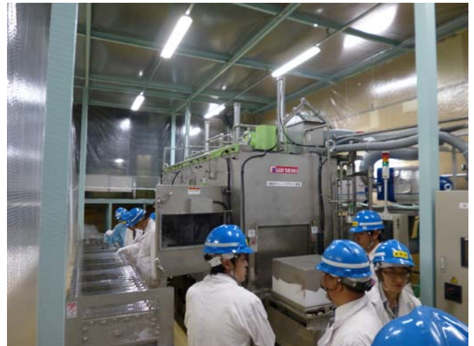
自動式ウェットブラスト除染装置 設置場所の現場視察
