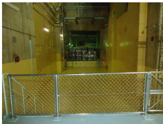
基礎コンクリートの解体後の状態
