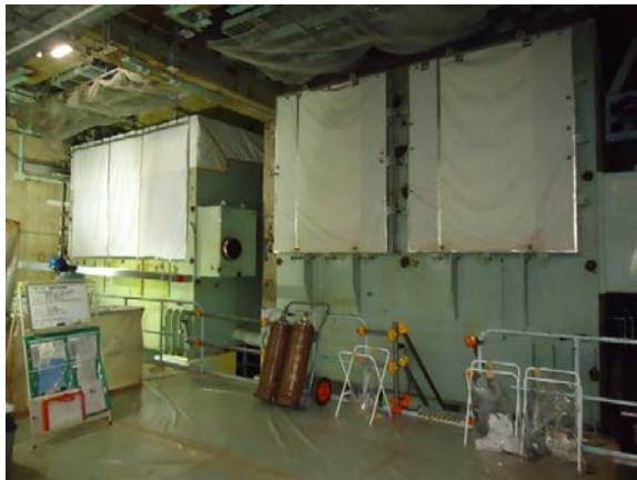
B 復水器下部胴等の解体前の状態
