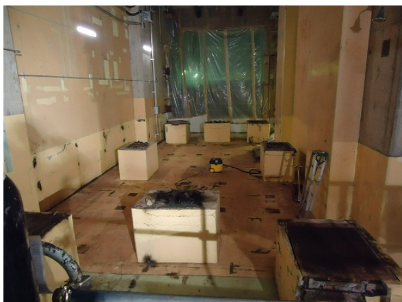
B号機下部胴の解体後の状況 (基礎コンクリートが残った状態)
