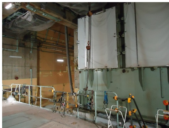
B 復水器下部胴等の解体後の状態
