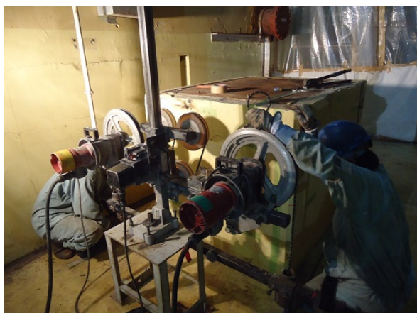
基礎コンクリートの解体状況 (ダイヤモンドワイヤーソーの設置状況)
