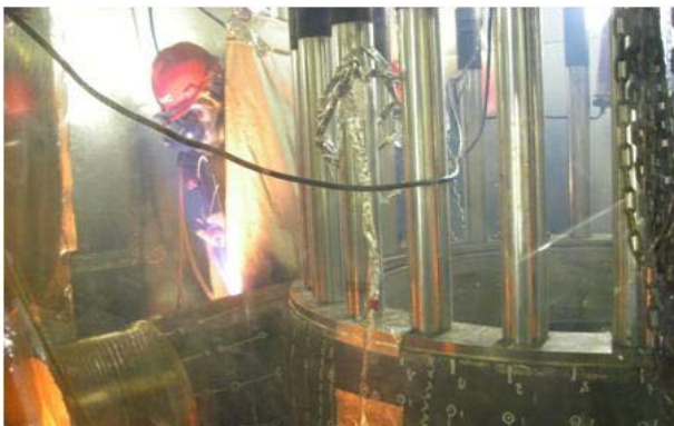
再循環ポンプケーシング試料採取状況 （ステンレス鋼鋳鋼～SCS13）
