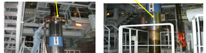
原子炉再循環系のステンレス配管採取箇所
